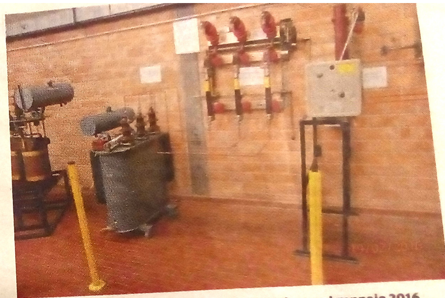
Un'immagine della sala prove in fase di costruzione nel gennaio 2016
